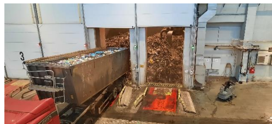
Fot. 6. Rozładunek odpadów do żelbetowego zbiornika na śmieci (bunkra)
